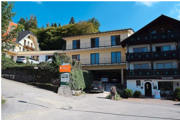
Das ehemalige Hotel Jägerstüble (re.) wurde über einen Neubau an das Murgtalblick Betreuungszentrum angeschlossen. Foto: Michel
